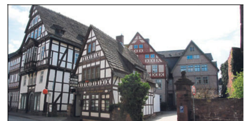
Der Heisterman von Ziehlbergsche Adelshof in Höxter: links das stattliche Tilly-Haus, das das Niedringhaus-Forum beherbergen soll.
